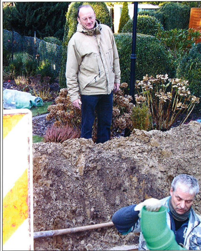
Joachim Daedlow aus dem Franziusweg ist erleichtert, dass es endlich losgeht, und verfolgt aufmerksam die Bauarbeiten auf seinem Grundstück.
